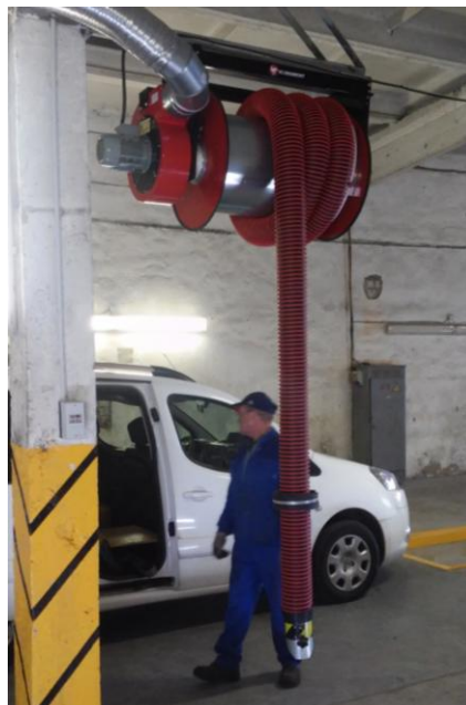
9 nuotr. Automobilių išmetamųjų dujų nutraukimo ir šalinimo ventiliacija.
